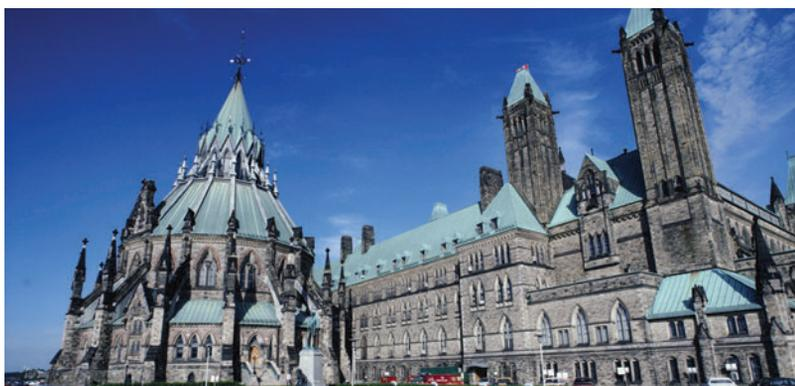
**Figure 3.14** À cause de la corrosion, la couleur du toit des édifices du Parlement à Ottawa est passée du brun-rouge au bleu-vert.
