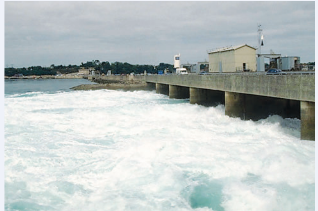
Centrale électrique marémotrice de La Rance en France.
