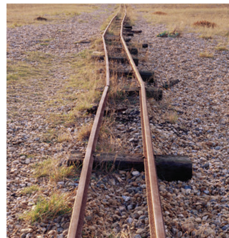
Figure 5.16 A) Vois-tu l'espace entre chacun de ces rails ? Cet espace empêche les rails de se pousser l'un l'autre et ainsi faire courber le chemin de fer quand il se dilate sous l'effet de la chaleur. B) Voilà ce qui arrive quand il n'y a pas assez d'espace entre les rails.
