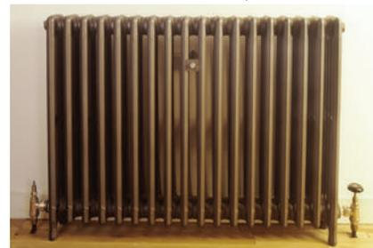
et des radiateurs permettent à l'air ambiant d'entrer en contact avec le métal chaud. Les plinthes de chauffage ont des ailettes et les radiateurs sont divisés en sections pour permettre un contact maximum avec l'air ambiant.
