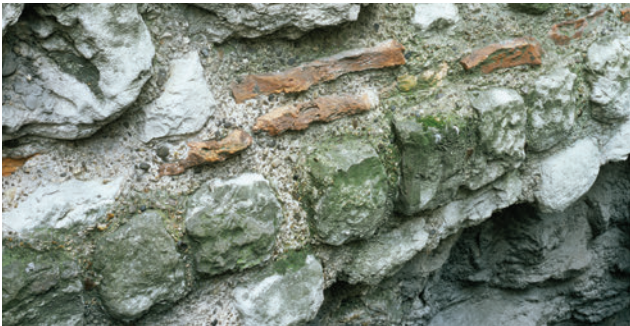
Ce mur romain a plusieurs milliers d'années. Il est fait de calcaire et de pavés romains, collés à l'aide de béton.
