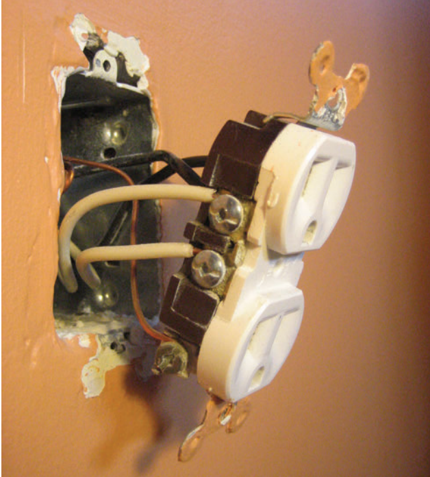
Figure 9.16 Les électrons sont « relâchés » dans un appareil électrique ou électronique en passant par les deux ouvertures de la prise. L'ouverture ronde dans la prise est reliée à une borne de mise à la terre à partir d'un fil de cuivre.
