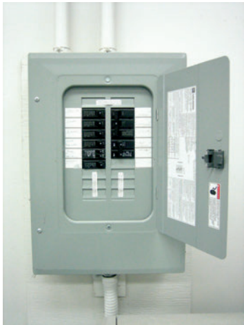
Figure 9.14 Les panneaux électriques se trouvent souvent au sous-sol. C'est de là que partent plusieurs circuits en parallèle. Chaque circuit est protégé par son propre disjoncteur.
