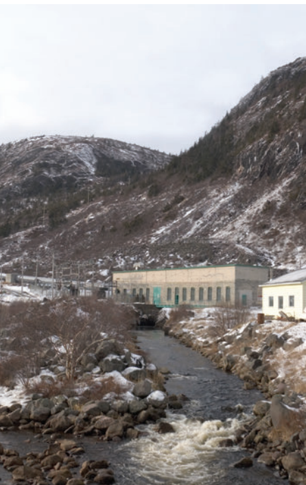
Figure 9.38 Plus de 90 % de l'énergie électrique produite à Terre-Neuve-et-Labrador provient de centrales hydroélectriques, comme celle-ci à Petty Harbour.
