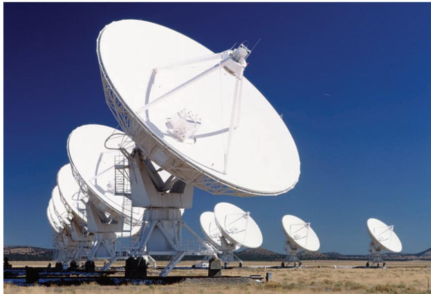
Il est possible de combiner plusieurs radiotélescopes pour obtenir les mêmes résultats qu'avec un seul télescope plus grand. Situé au Nouveau-Mexique, l'observatoire à très large spectre VLA (*Very Large Array*) comprend 27 antennes disposées à 25 m l'une de l'autre (voir la figure 11.37). Ce qui équivaut à un radiotélescope qui mesurerait 36 km de large!
