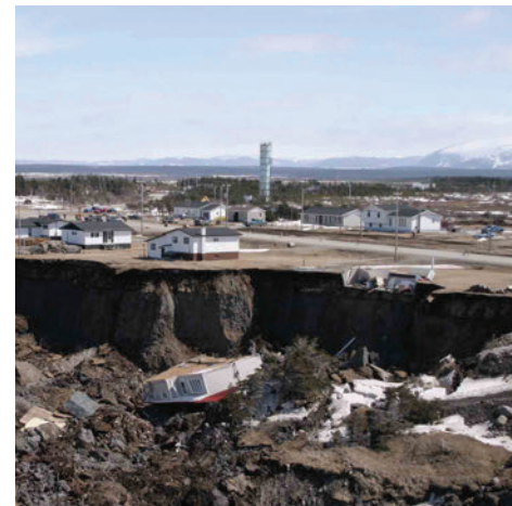
Figure 12.9 Des pluies abondantes au-dessus de la falaise, et l'érosion dans le bas, ont provoqué des glissements de terrain à Daniel's Harbour, sur la côte ouest de l'île de Terre-Neuve, en 2006 et en 2007.
